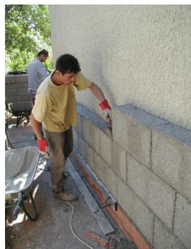
/ Mise en œuvre de bloc de chanvre en isolant extérieur (Crédit photo : Chanvre Bloc)
