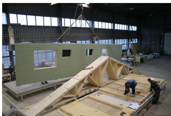
/ Usine de pré-montage de maisons à ossatures bois (crédit photo : Maison Eco Malin)
