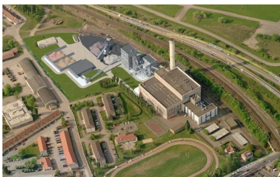
/ Extension de la centrale de Chambièrre
